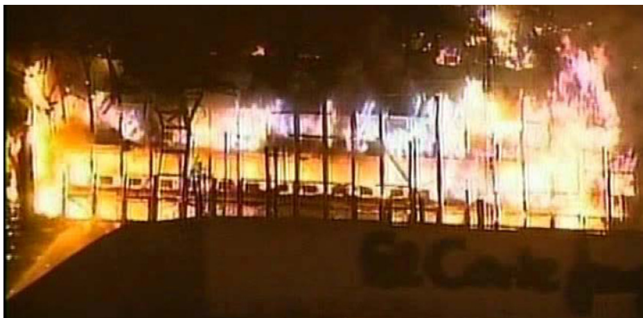
Vertikal Brandspridning via fasaden under branden i Torre Windsor, Madrid 2005.
